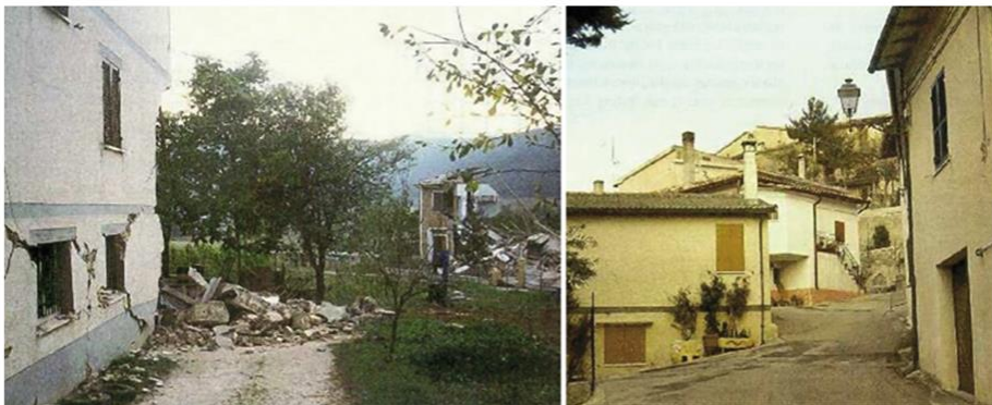
Terremoto Umbria-Marche, 1997. Differenza di danneggiamento in località vicine, dovute ad effetti locali. A sinistra Cesi Bassa (IX MCS), a destra Cesi Villa (VII MCS) (illustrazione tratta da: Indirizzi e criteri per la microzonazione sismica, Parti I e II, a cura di F. Bramerini, G. Di Pasquale, G. Naso, M. Severino, Presidenza del Consiglio dei Ministri, Dipartimento della protezione civile, Roma, 2008)
